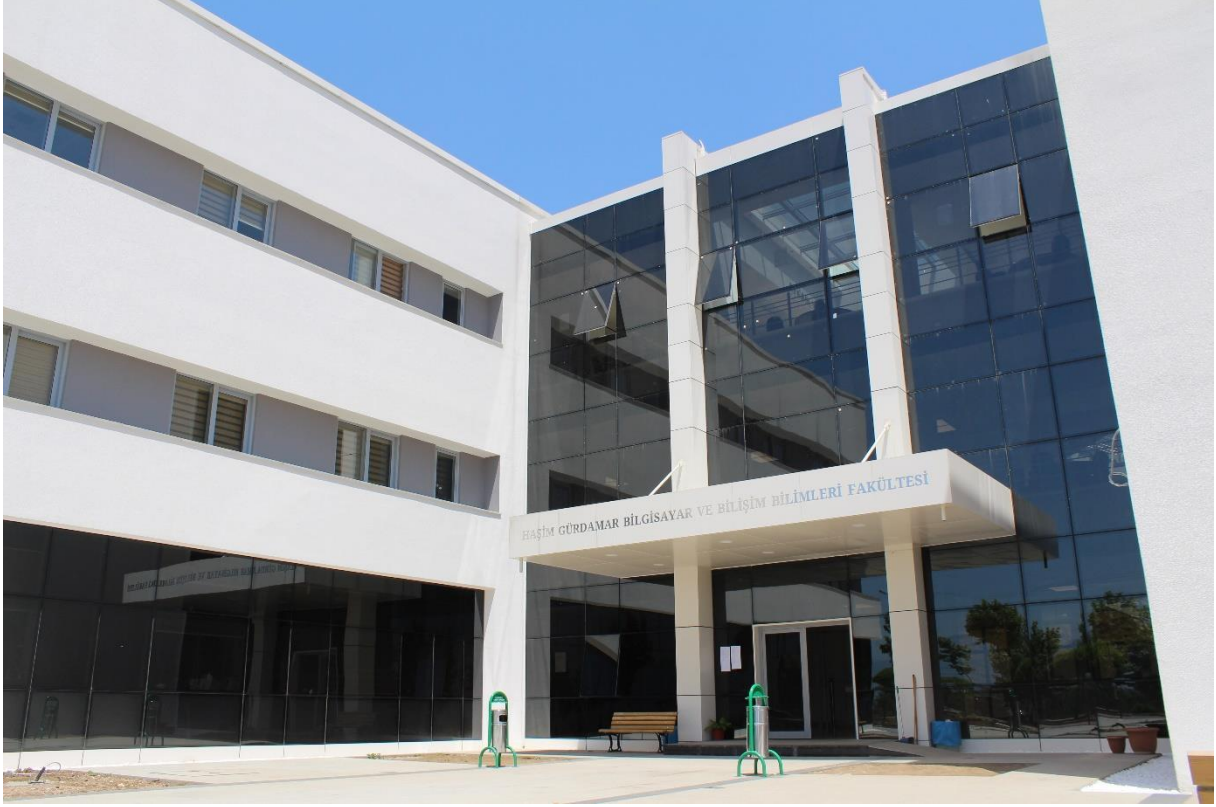
Haşim Gürdamar Bilgisayar ve Bilişim Fakültesi Binası
