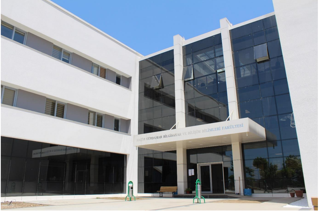
Haşim Gürdamar Bilgisayar ve Bilişim Fakültesi Binası
